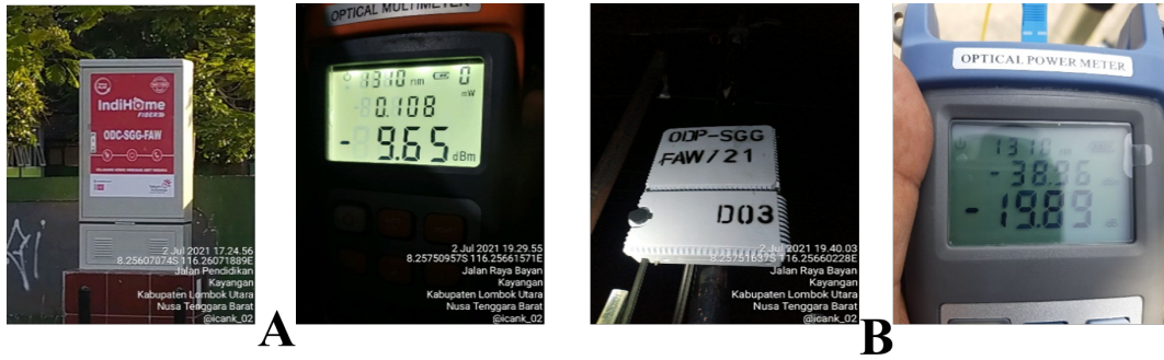
Gambar 8. Proses Pengukuran Redaman pada ODC (A) dan pada ODP (B)
