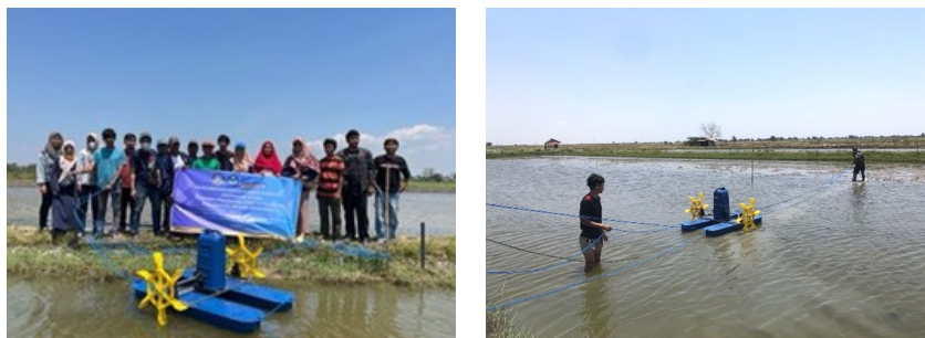
Gambar 5. Dokumentasi Pemasangan Sistem Aerator Tambak Udang
