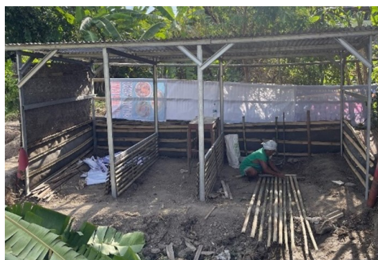
Gambar 3. Proses Pembangunan Kandang itik Petelur
