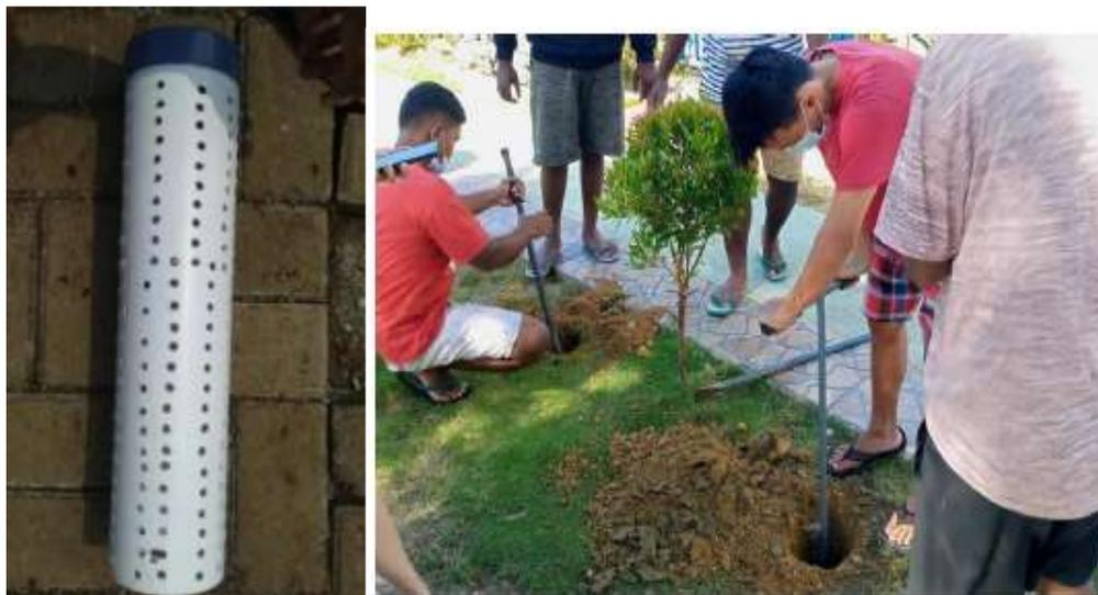
Gambar 4. Pipa PVC biopori dan proses pengeboran dengan bor biopori
